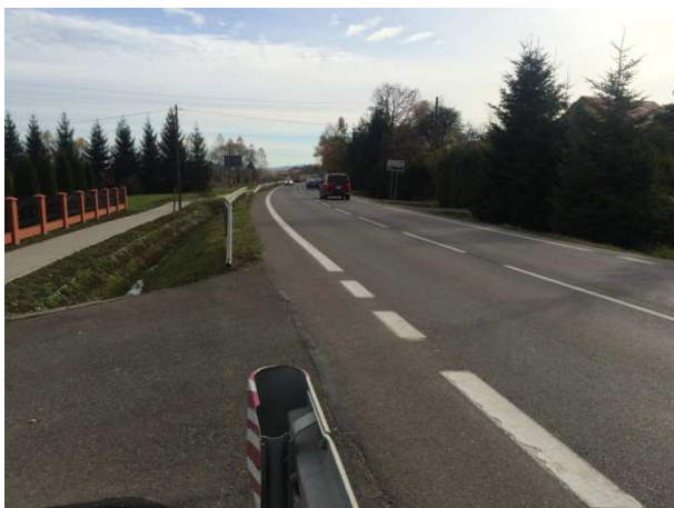
Pakoszówka, widok w kierunku południowym
